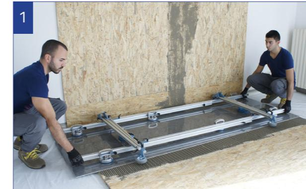
Posa a terra con telaio di movimentazione KERA-LIFT.
